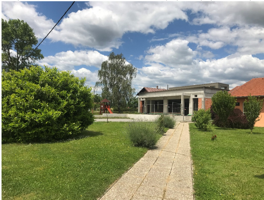
Slika 10.: Dječji vrtić Gornji Fodrovec u izgradnji
