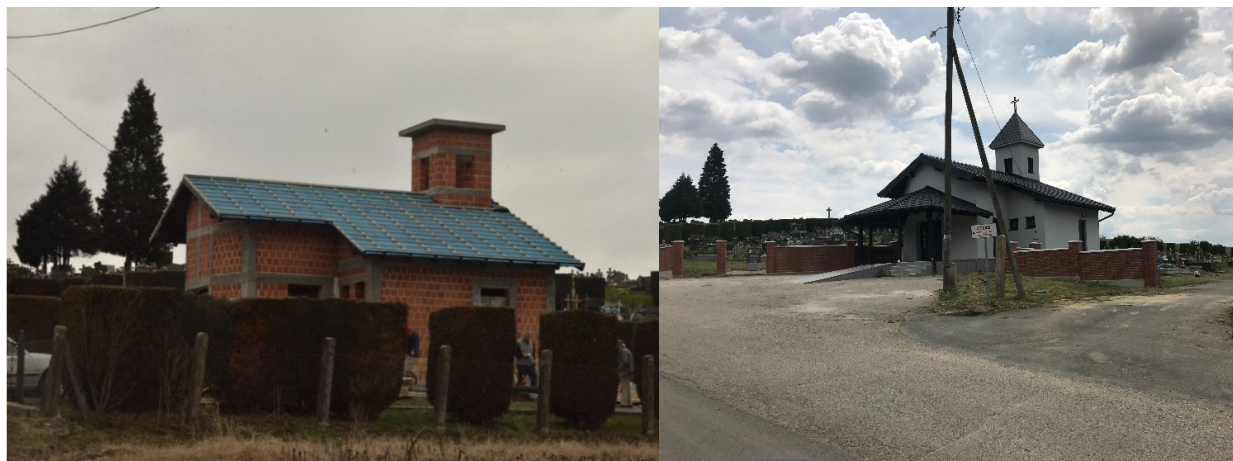
Slika 4.: Uređenje mrtvačnice u Miholcu i izgradnja ogradnog zida
