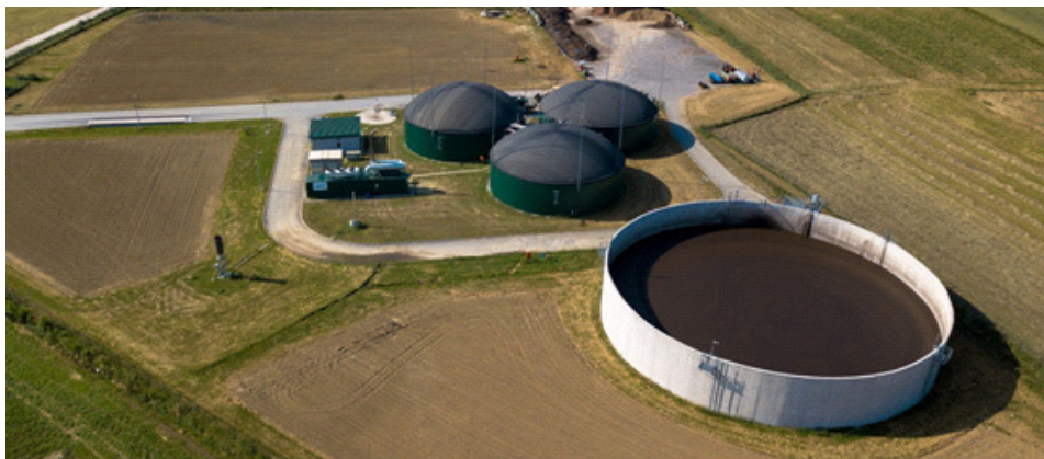
Bioplinarsko postrojenje Bioplinarske elektrane Orehovec, Sveti Petar Orehovec
