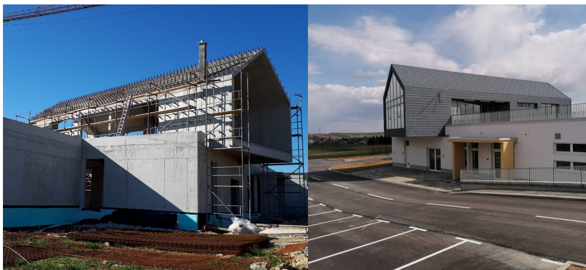
Slika 9.: Dječji vrtić „Mali Petar“ Sveti Petar Orehovec u izgradnji i po završetku
