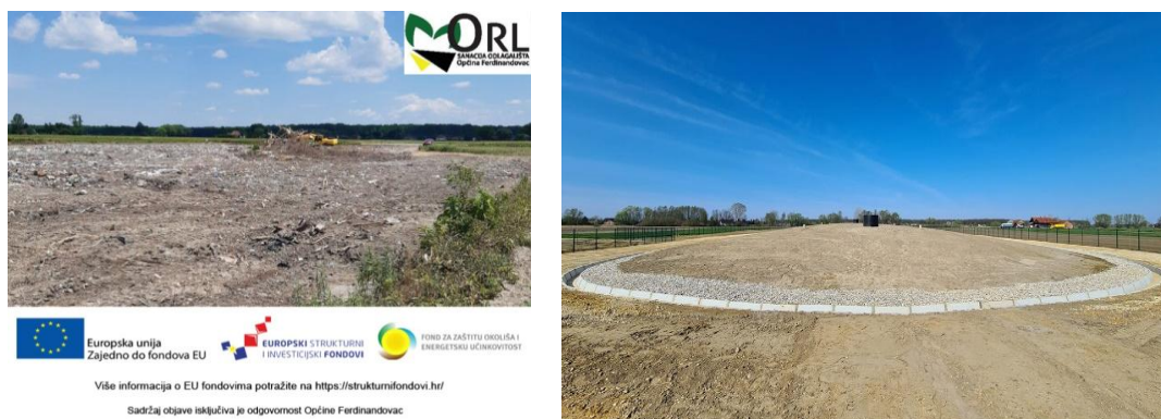
Slika 12: Odlagalište otpada Ferdinandovac, sanacija u tijeku i nakon sanacije (Izvor: https://www.ferdinandovac.hr/index.php/opcina-ferdinandovac/orl-projekt )
