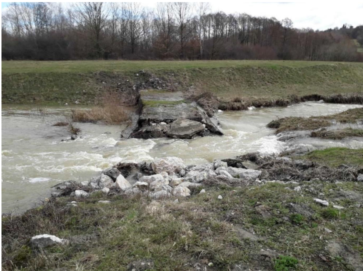
Sl. 1.2-17 Aktivacija bočnog preljeva tj. odvodnog (preljevno) kanala
