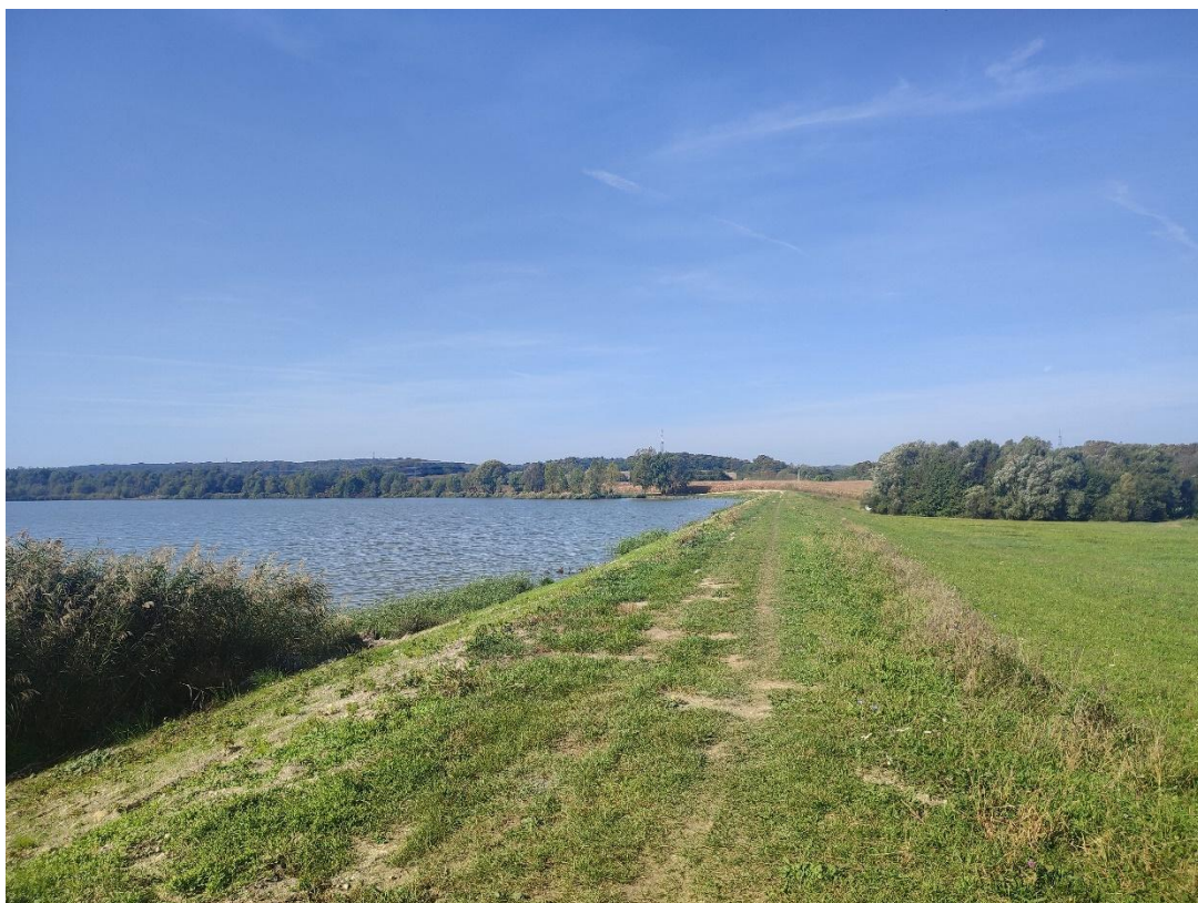
Sl. 1.2-8 Brana na akumulaciji Rasinja
