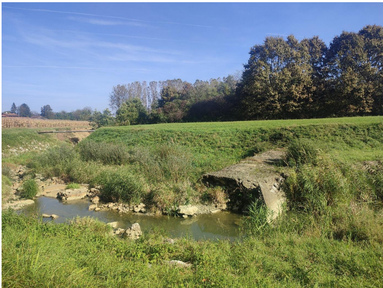
Sl. 1.2-16 Trenutno postojeće stanje kaskada odvodnog (preljevnog) kanala (listopad 2023)
