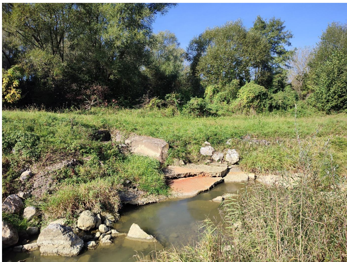
Sl. 1.2-11 Lokacija spoja kanala temeljnog ispusta i vodotoka Gliboki (listopad 2023)
