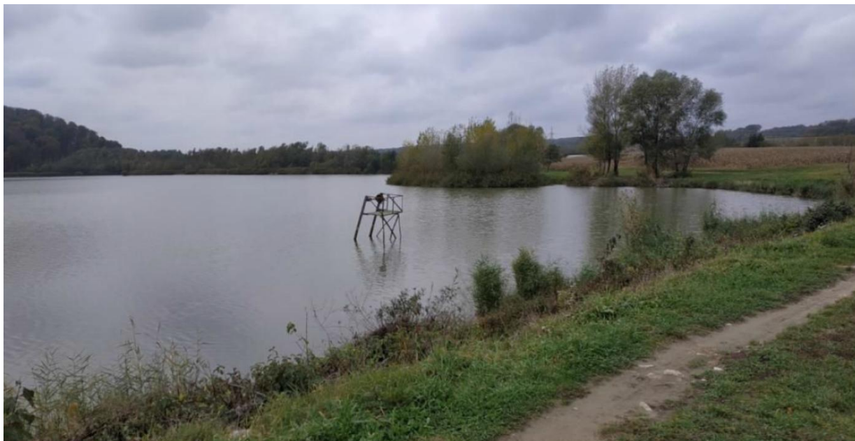
Sl. 1.2-9 Ulazna građevina temeljnog ispusta
