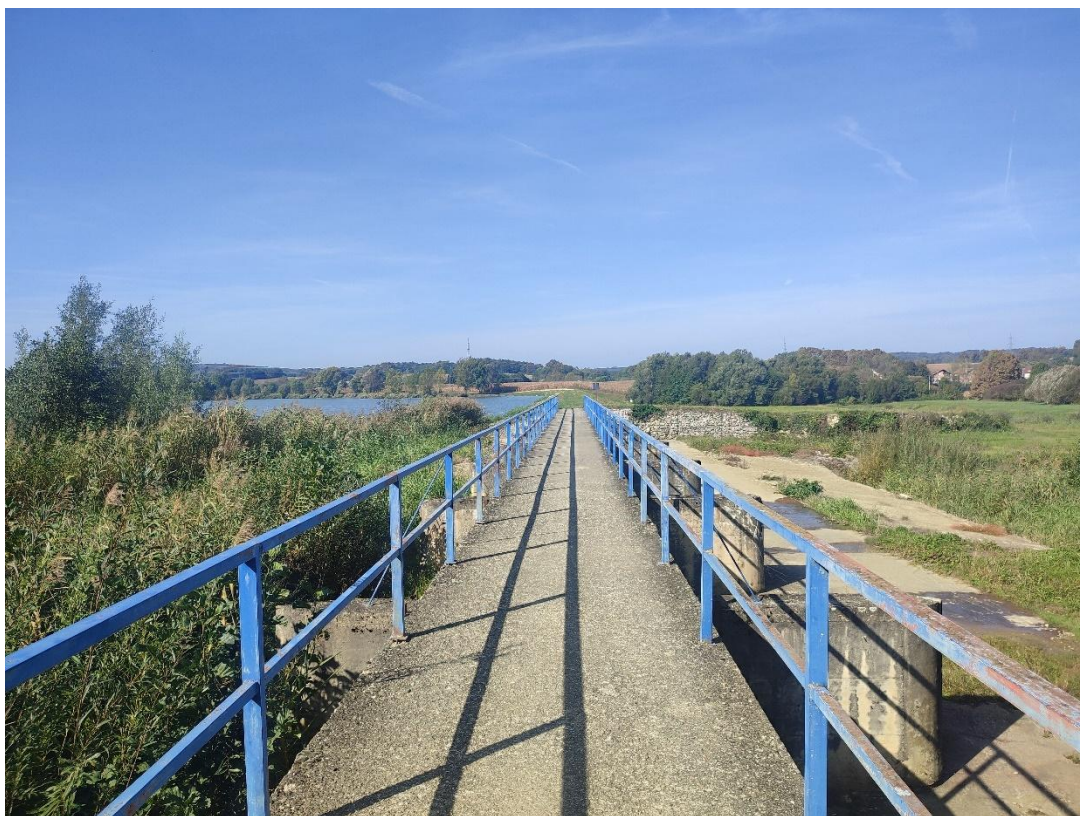
Sl. 1.2-7 Prilaz brani preko mosta iznad bočnog preljeva
