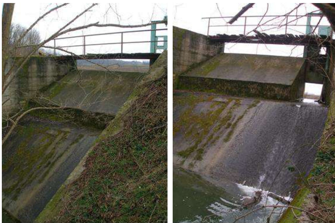
Slika 2-7: Preljevna građevina u sadašnjem stanju
