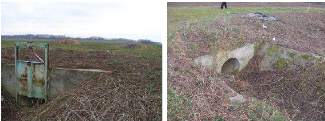
Slika 2-6: Temeljni ispušt na zapadnom bočnom nasipu (pogled s unutrašnje i vanjske strane retencije)
