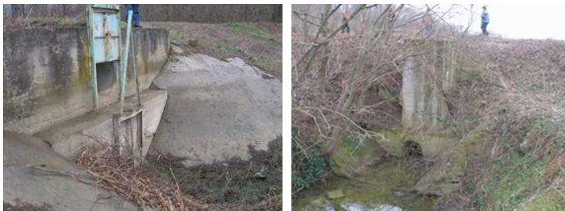
Slika 2-5: Temeljni ispust na sjevernom djelu (pogled s unutrašnje i vanjske strane retencije)
