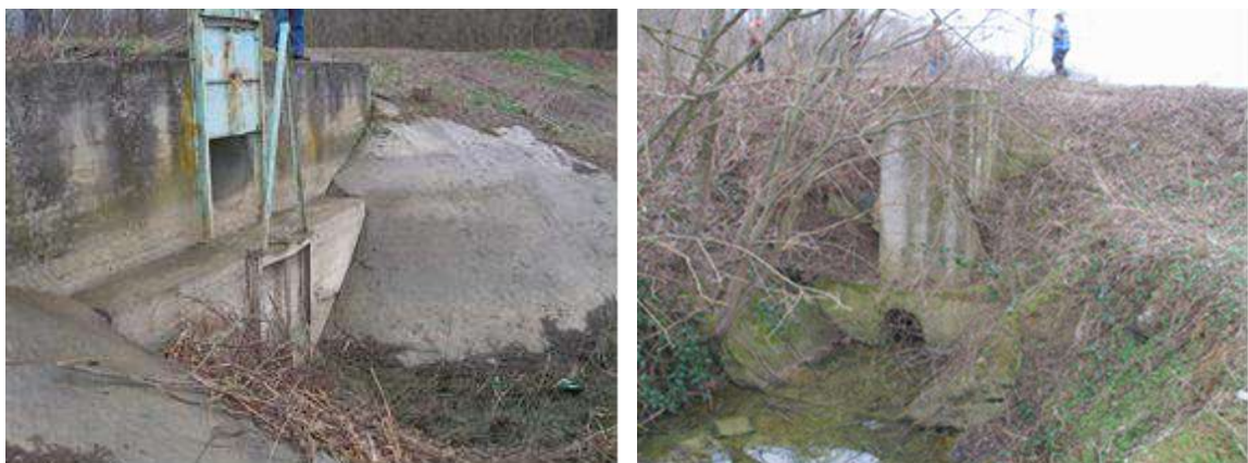
Slika 2-5: Temeljni ispust na sjevernom djelu (pogled s unutrašnje i vanjske strane retencije)
