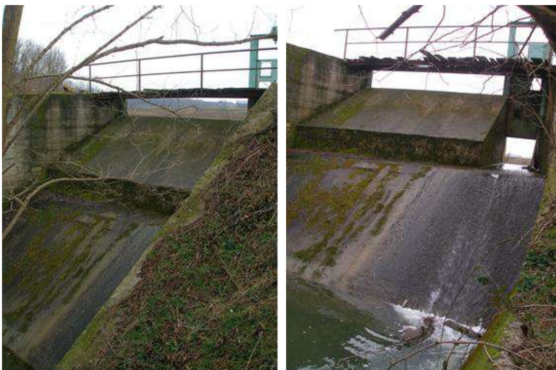
Slika 2-7: Preljevna građevina u sadašnjem stanju
