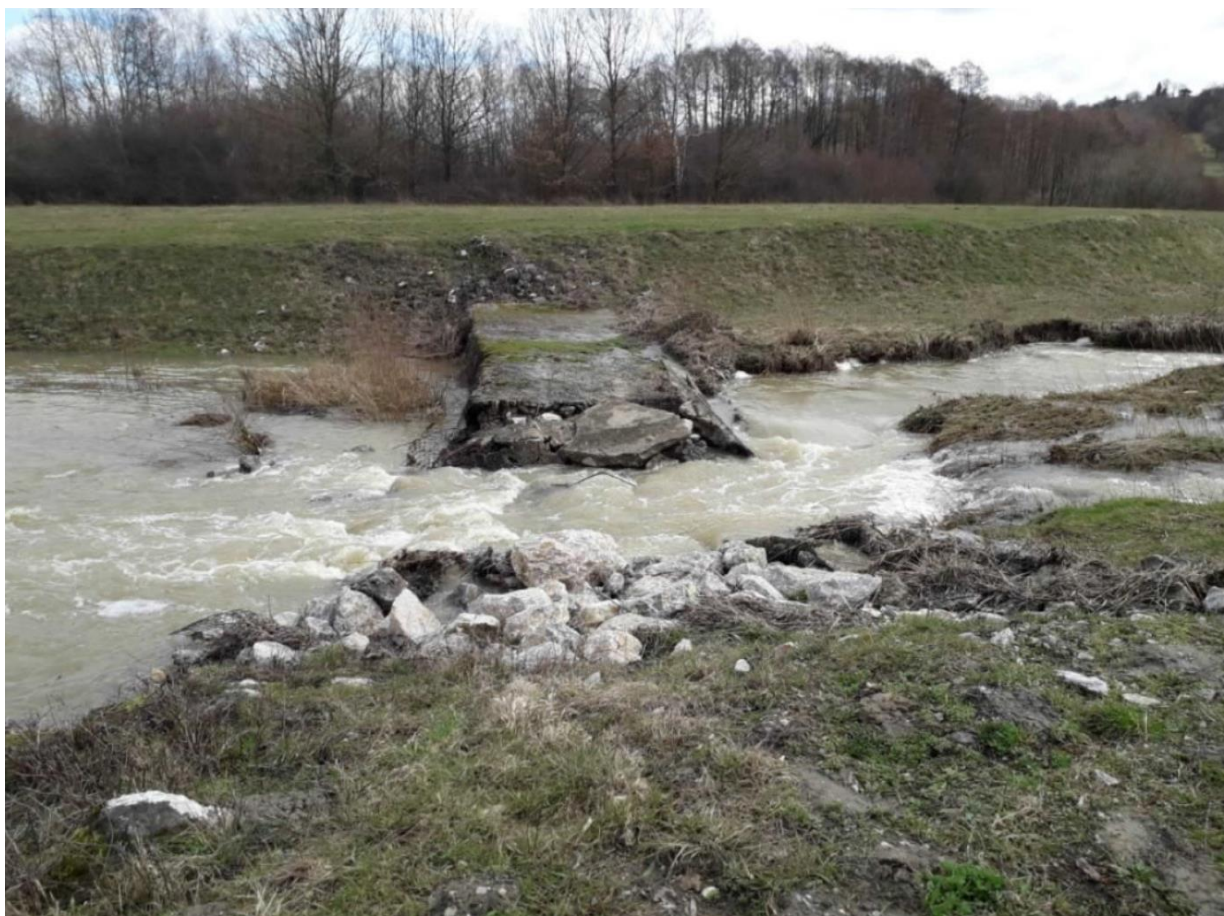
Sl. 1.2.16 Aktivacija bočnog prejeva tj. odvodnog (prejevnog) kanala
