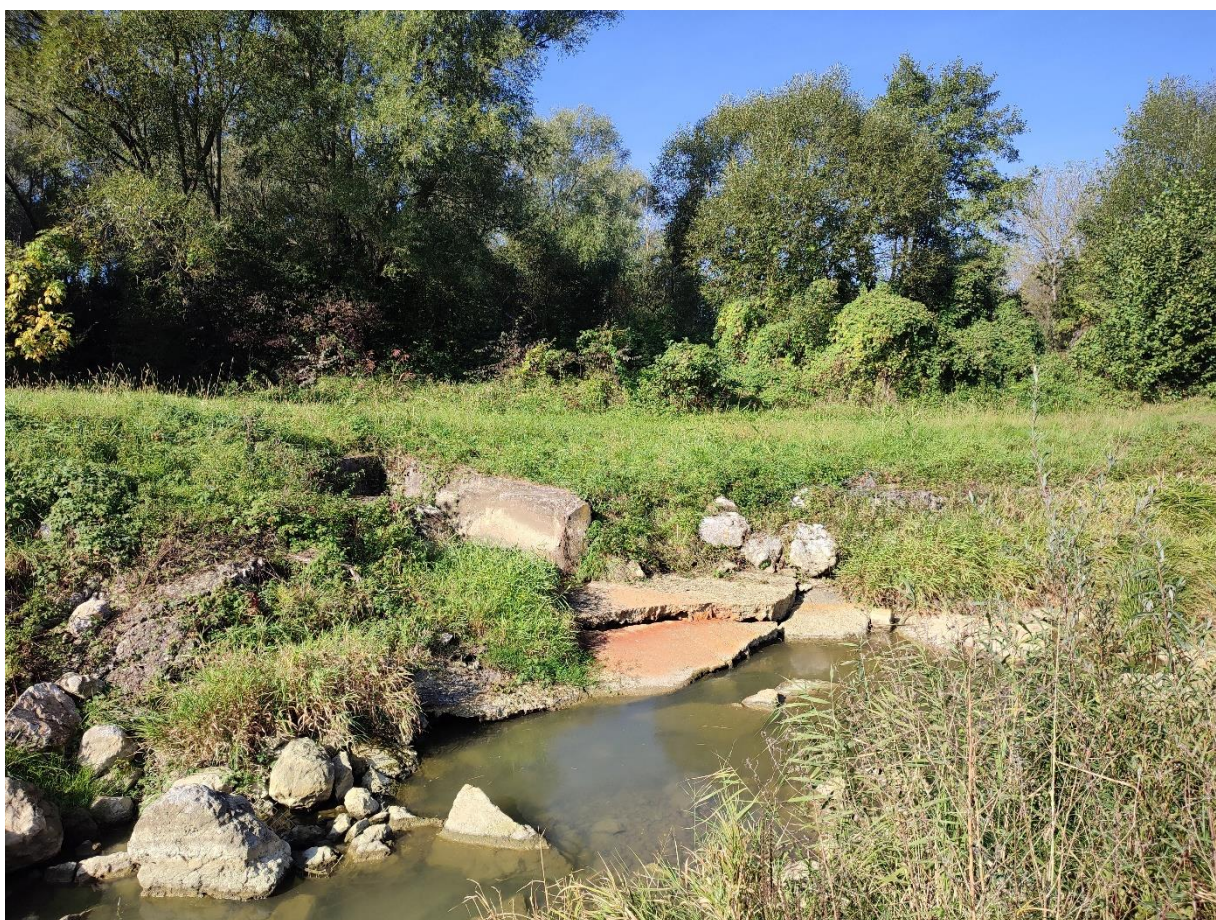
Sl. 1.2.10 Lokacija spoja kanala temeljnog ispusta i vodotoka Gliboki (listopad 2023)
