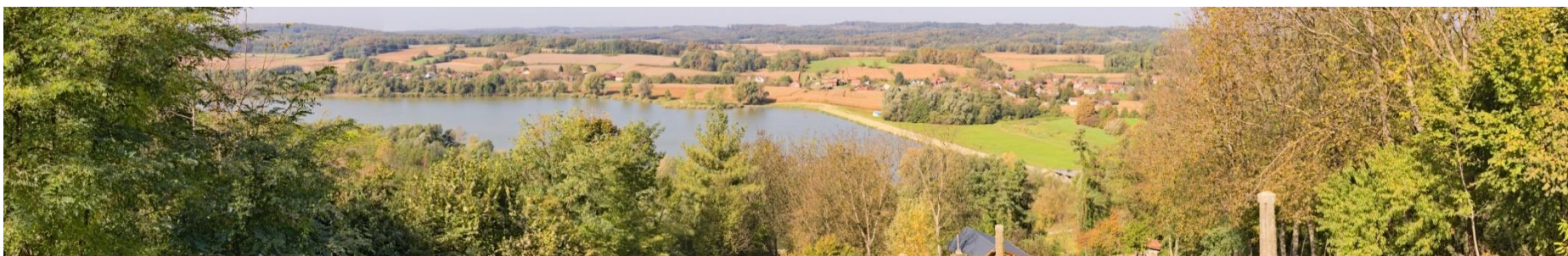
Sl. 3.12.8: Točka 31: Panoramska snimka pogleda na akumulaciju i brane s brežuljkastog područja istočno od pregrade, pogled na zapad
