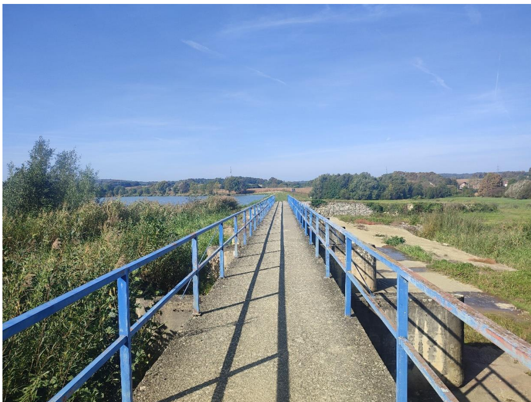
Sl. 1.2.6 Prilaz brani preko mosta iznad bočnog preljeva
