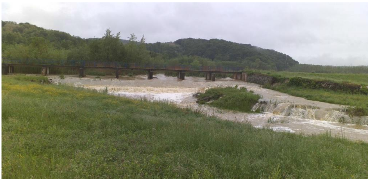
Sl. 1.2.14 Aktivacija bočnog preljeva
