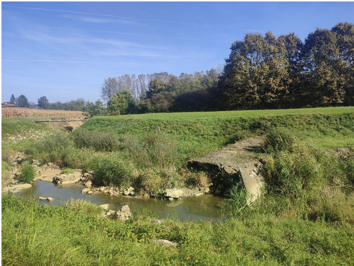
Sl. 1.2.15 Trenutno postojeće stanje kaskada odvodnog (preljevno) kanala (listopad 2023)
