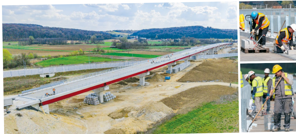
U tijeku su intenzivni radovi na svim dijelovima buduće ceste
